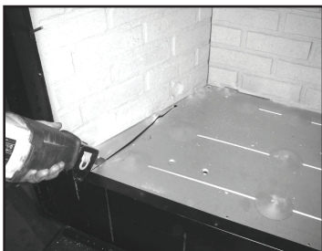
Figure 12.2 - Découpez le fond en utilisant une scie alternative.
