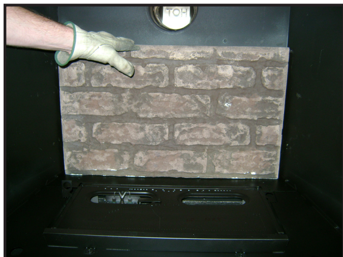
Figure 4.5 Retrait du réfractaire arrière
