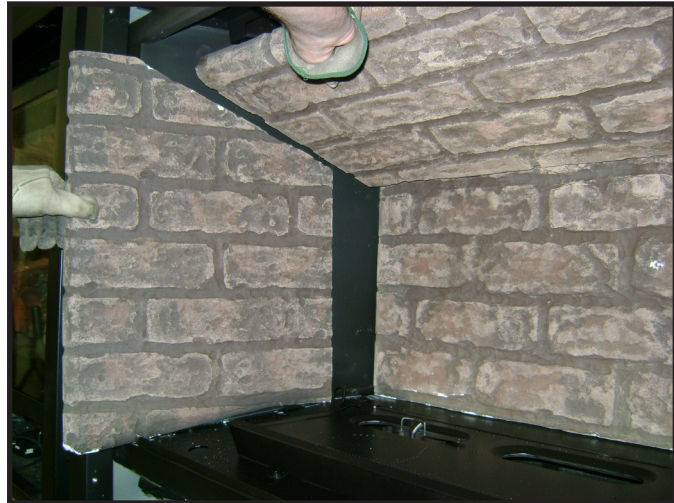
Figure 4.3 Démontage du réfractaire supérieur
