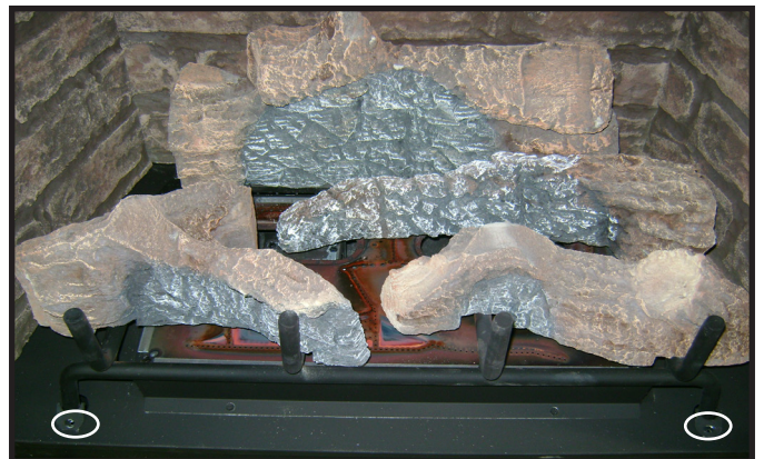
Figure 4.7 Retrait des vis des languettes frontales
