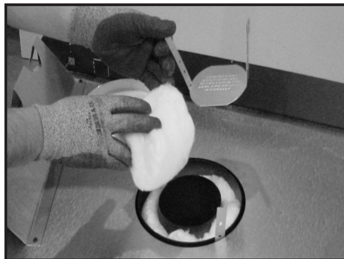
Figure 6.4 (représentation d'un foyer générique) Retirez le panier d'isolation et l'isolant blanc du centre du conduit d'évacuation des gaz.
