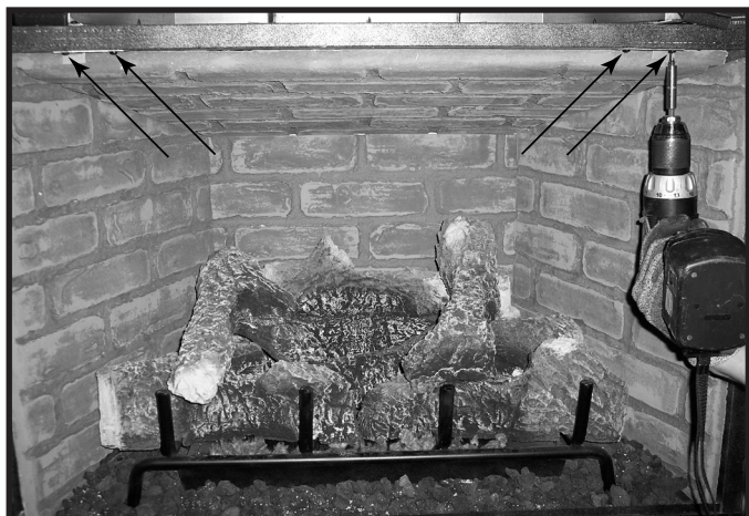
Figure 4.13 Retrait des dispositifs de retenue du réfractaire
