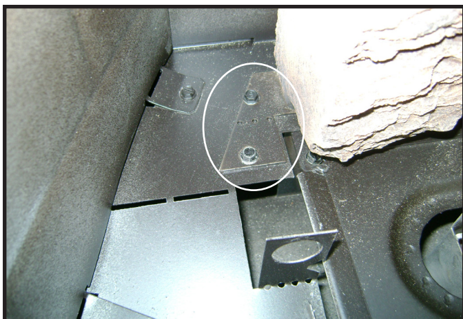
Figure 4.5 Retirez les deux vis des languettes de la bûche
