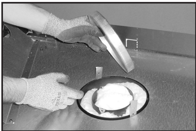
Figure 6.3 (représentation d'un foyer générique) Enlevez le couvercle du conduit.
