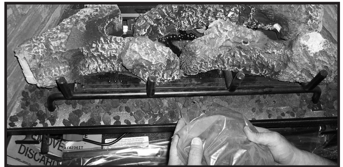
Figure 11.4 Placement de la pierre de lave
