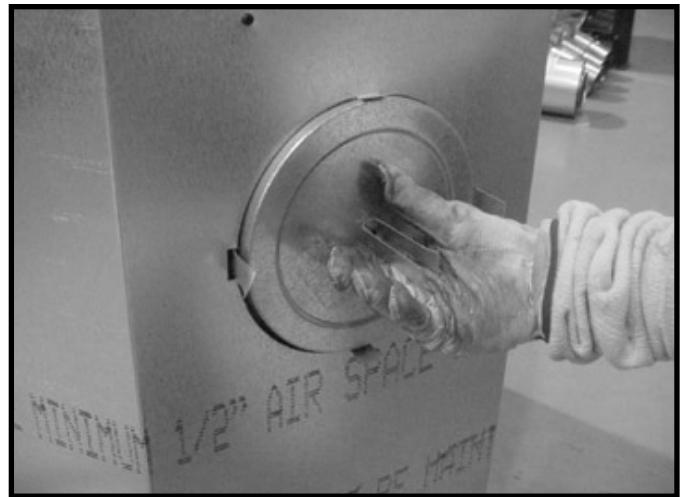
Figure 6.9 (représentation d'un foyer générique) Repliez vers l'extérieur les parties centrales de la bande de retenue et les utiliser pour enlever le couvercle du conduit.
