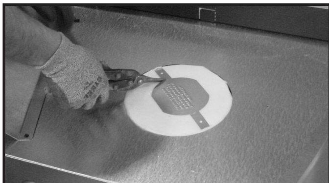
Figure 6.1 (représentation d'un foyer générique) Coupez la bande de suspension du couvercle du conduit, à travers les rectangles jouxtant le disque.
