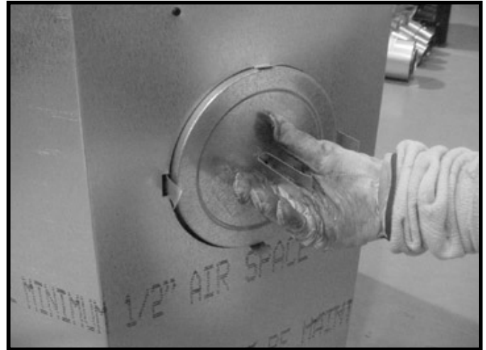
Figure 6.9 (représentation d'un foyer générique) Repliez vers l'extérieur les parties centrales de la bande de retenue et les utiliser pour enlever le couvercle du conduit.
