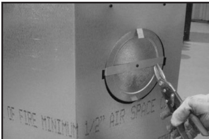
Figure 6.8 (représentation d'un foyer générique) Coupez la bande métallique de retenue et pliez les deux parties coupées vers l'extérieur.
