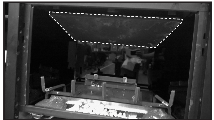
Figure 3. Installer le panneau réfractaire supérieur
