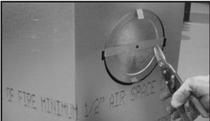
Figure 6.8 (représentation d'un foyer générique) Coupez la bande métallique de retenue et pliez les deux parties coupées vers l'extérieur.
