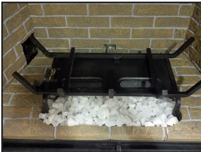
Figure 11.20. Zone de braises couverte avec du Teco-Sil
