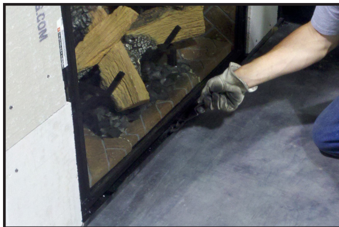
Figure 11.8. Sécuriser les clips de verre inférieurs
