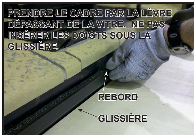
Figure 11.6. Installer la vitre
