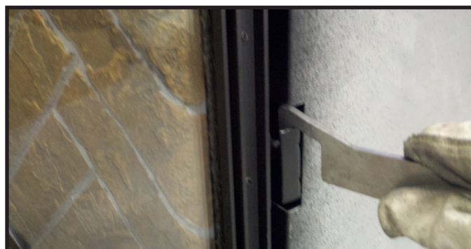
Figure 11.7. Sécuriser les clips de verre latéraux
