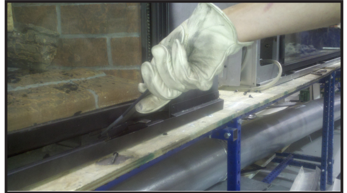
Figure 11.3. Insérer l'outil du clip de vitre
