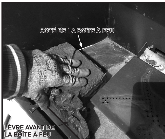
Figure 11.3 Installer le composant de l'âtre de gauche
