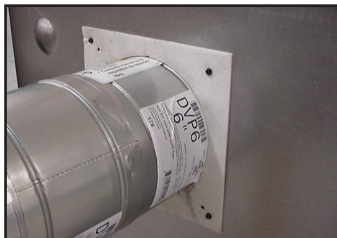
Figure 6.13 (représentation d'un foyer générique) Posez la première section du conduit d'évacuation (elle s'insèrera en place d'un bruit sec). Glissez le joint d'isolation sur cette section du conduit, contre l'appareil, en passant sur les languettes. Utilisez deux vis autotaraudeuses pour fixer le joint à l'enveloppe extérieure.
