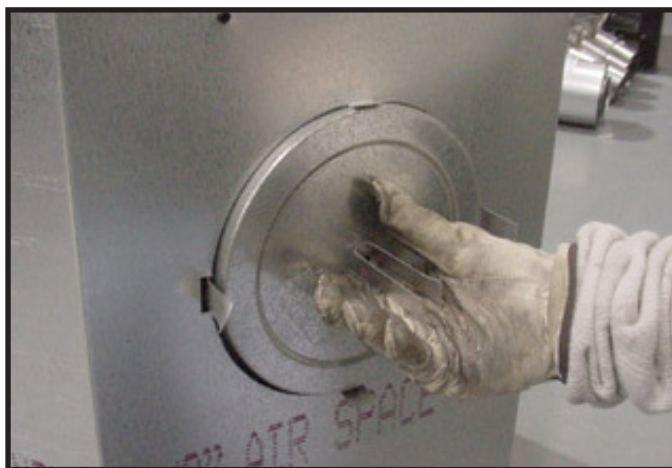
Figure 6.11 (représentation d'un foyer générique) Repliez vers l'extérieur les parties centrales de la bande de retenue et les utiliser pour enlever le couvercle du conduit.
