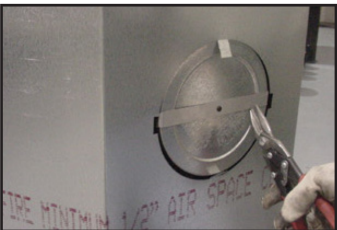
Figure 6.10 (représentation d'un foyer générique) Coupez la bande métallique de retenue et pliez les deux parties coupées vers l'extérieur.
