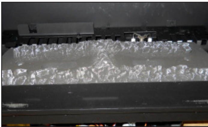
Figure 10.6 Installation du réfractaire arrière
