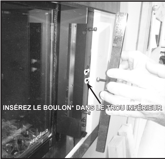
Figure 10.25. Installer les pièces latérales de granite
