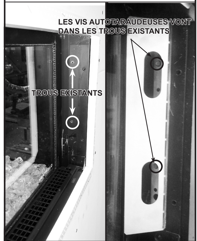
Figure 10.15 Installer le support du panneau de verre de transition
