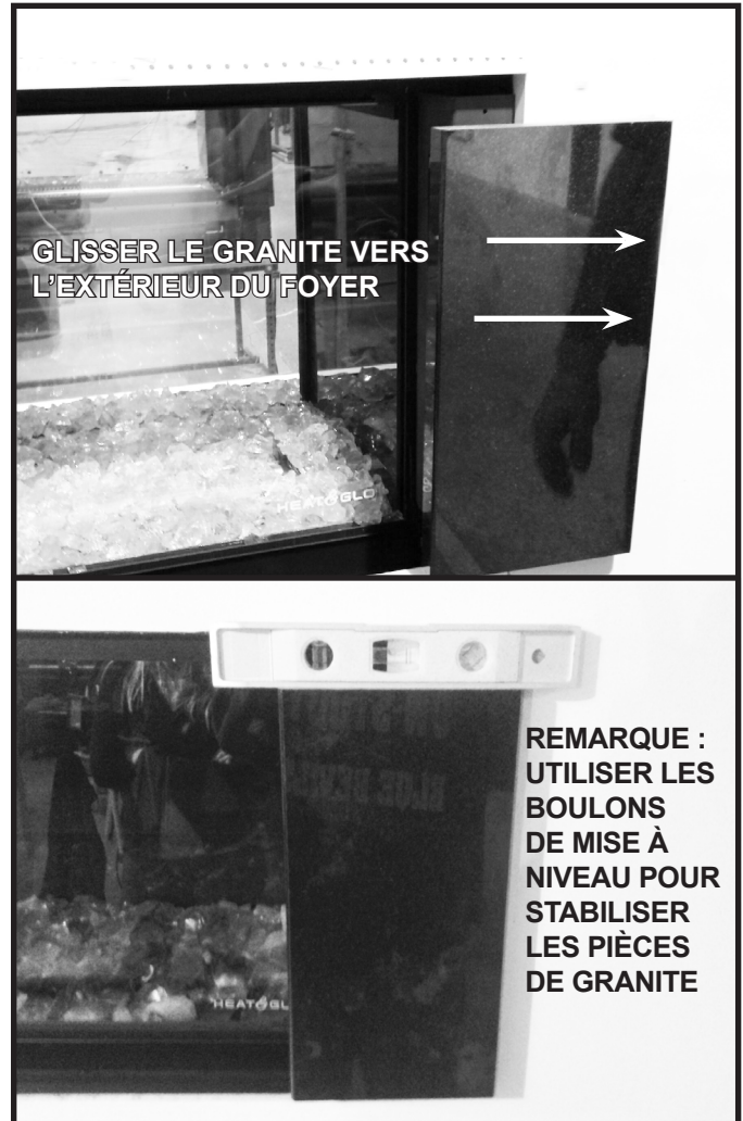
Figure 10.26. La pièce de granite de droite est installée et mise à niveau
